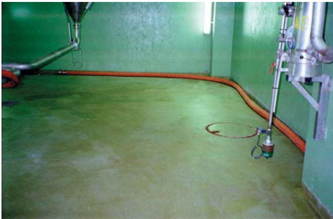
Метилметакриловое покрытие DURACON® толщиной 5 мм, 20 лет в эксплуатации — пивоваренный завод Adelshoffen, г. Страсбург (Франция)
